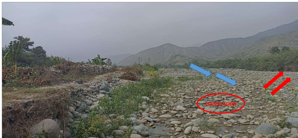
FIGURA N°03: TRAMOS DEL CAUCE DEL RIO CHANCAY - HUARAL EN EL SECTOR BOCATOMA PALPA - HORNILLOS, EN LA PROGRESIVA KM 25+750 SE ENCUENTRA COLMATADO DE MATERIAL GRANULAR Y FINO SEDIMENTADO, PRODUCIENDOSE LA REDUCCIÓN DE LA SECCIÓN HIDRÁULICA.
