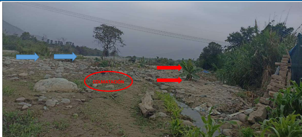
FIGURA N°01: RIO CHANCAY - HUARAL COLMATADO EN EL SECTOR BOCATOMA PALPA-HORNILLOS, CON LA PRESENCIA DE: VEGETACIÓN, ARENA FINA Y MATERIAL GRANULAR; LAS CUALES DEBEN SER DESPLAZADOS HACIA AMBOS MARGENES PARA MANTENER SU SECCIÓN HIDRÁULICA .
